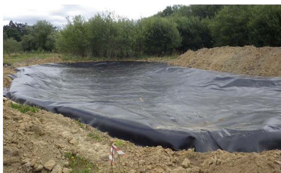
Figura 7.7.4. Creación de medios ecotónicos mediante impermeabilización y biotopos húmedos.
