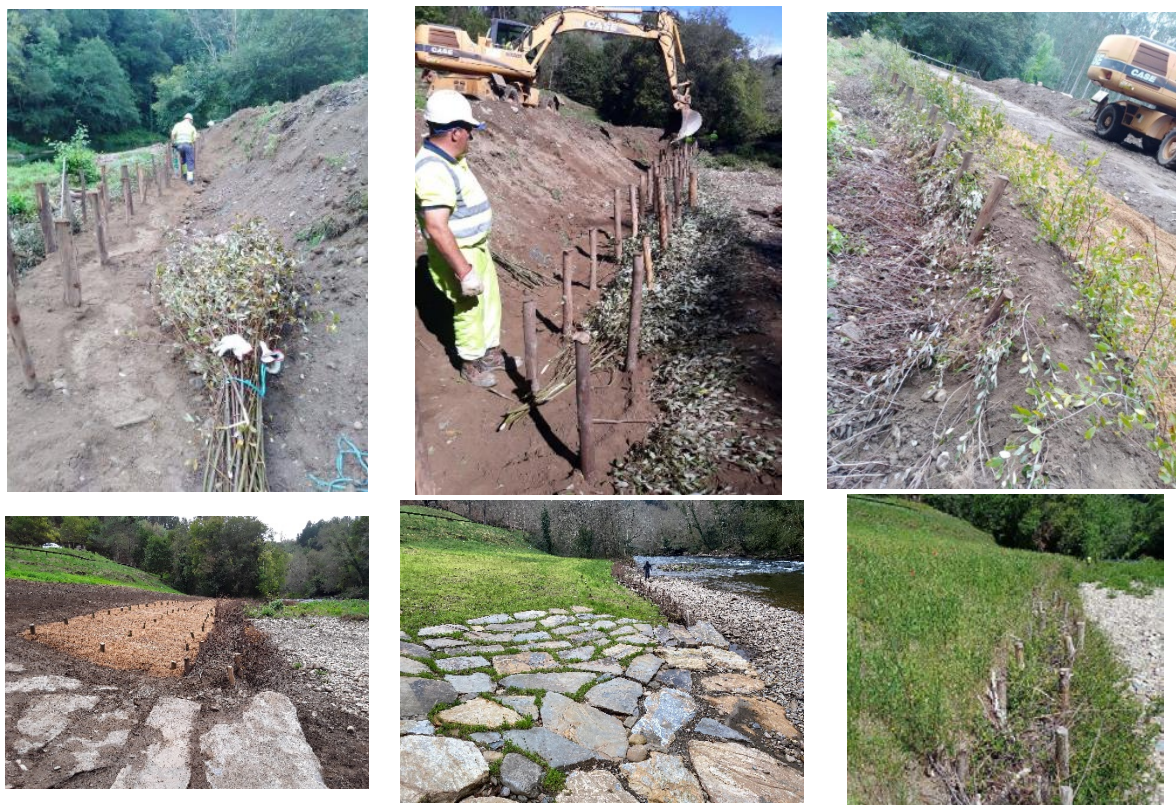
Figura 5.6.2. Secuencia temporal de la obra de bioingeniería y vista general de la actuación una vez finalizada.
