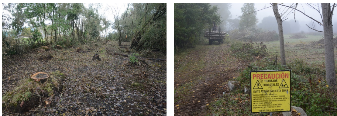
Figura 7.5.2. Vista parcial de bosque higrófilo (91E0*) en el que se ha hecho eliminación de especies invasoras arboladas en A Lagoa do Rei, y saca de madera mediante tractor autocargador transitando por los caminos del enclave.
