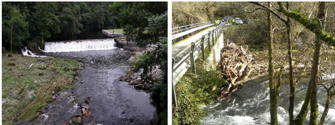
Figura 5.2.2. Azud que rompe la continuidad longitudinal del río Eo a su paso por Ribeira de Piquín (Lugo) y puente con gran acumulación de restos de madera muerta provocando una reducción importante de la sección del cauce del río Eo en A Pontenova (Lugo).
