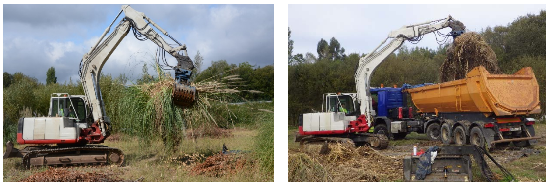
Figura 7.7.2. Eliminación mecanizada de Cortaderia selloana y carga en camión para transporte a gestor de residuos.
