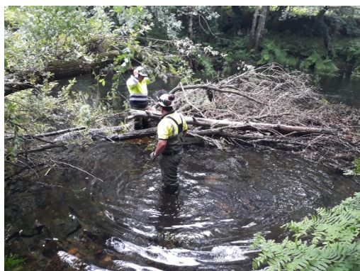
Figura 7.3.3. Saca de madera por flotación y con chimpín en el río Parga-Guitiriz.
